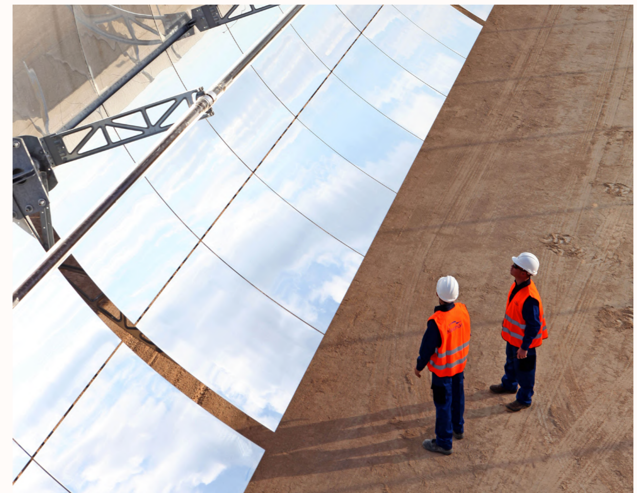
Serviço de manutenção em ASTEXOL-2
