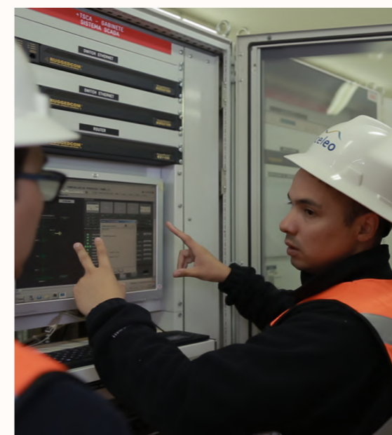
Serviço de manutenção na subestação Hualqui
