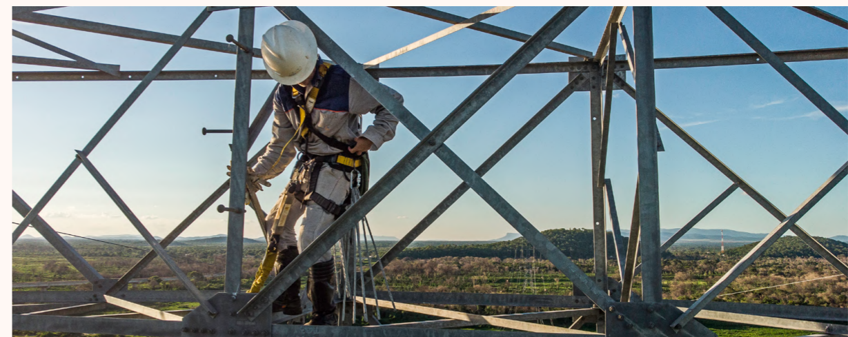
Serviços de energização na PATE
