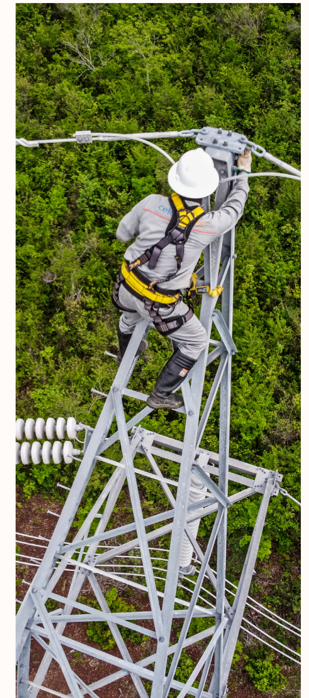
Serviço de manutenção na SITE
